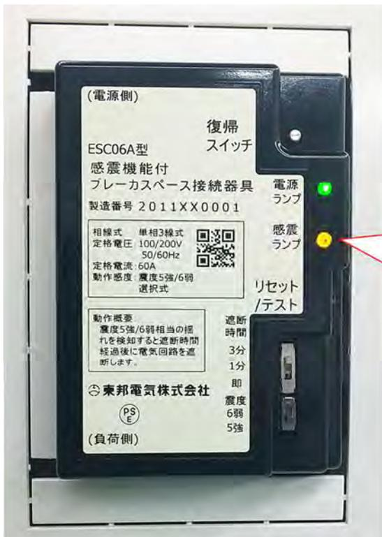
③ 感震ランプ(黄)が連続点灯、ブザーが連続音に変化し、電気を即時に遮断します。
