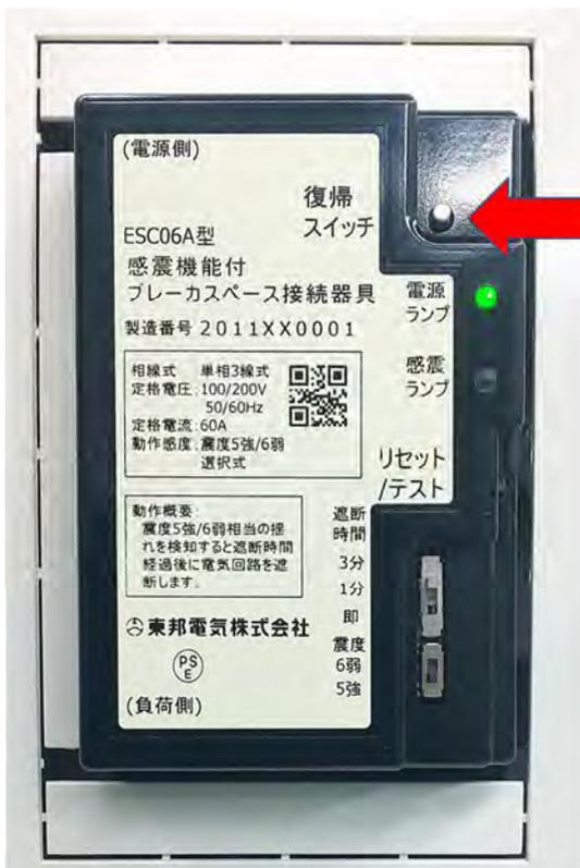
② 復帰スイッチを4秒以上押し続けます。開閉器が動作し、電気が遮断されます。
