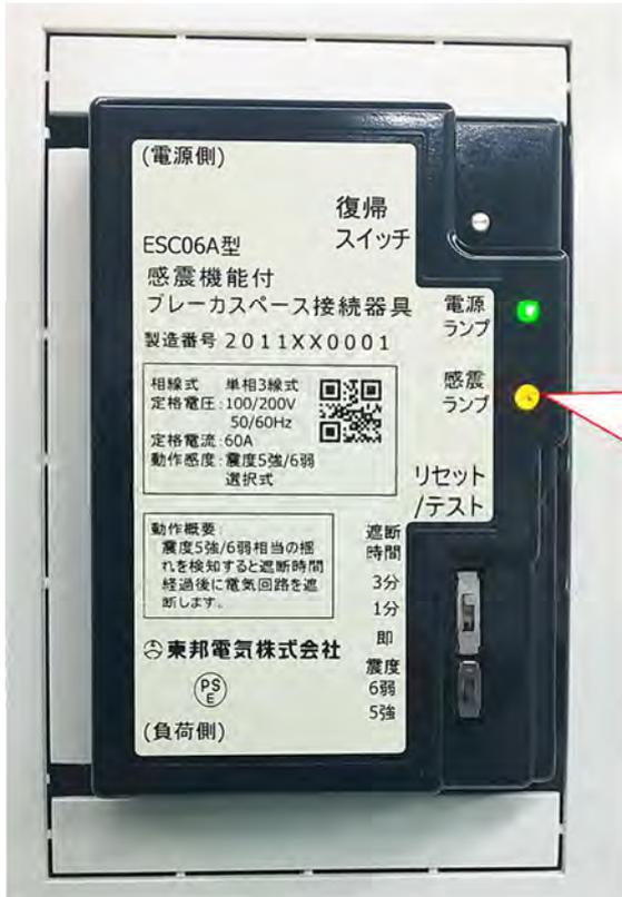
① 感震ランプ(黄)が点滅または連続点灯し、ブザーが鳴動していることを確認します。
